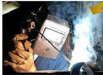
アーク溶接作業により発生した溶接ヒューム（湯気状に見えるもの）
